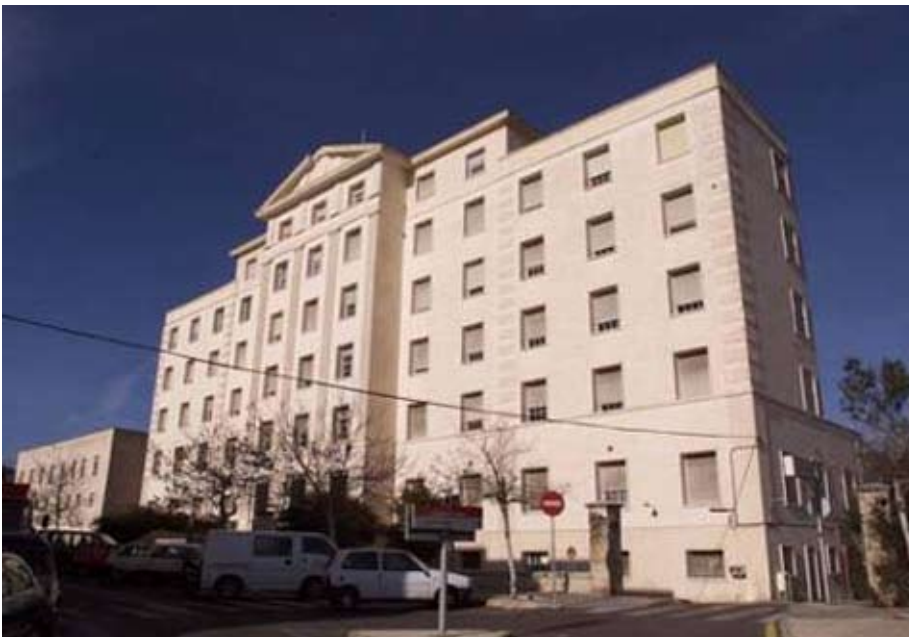
Una imatge de l'antic hospital Verge del Toro, que es convertirà en centre sociosanitari.
